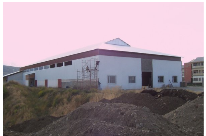
The new gymnasium under construction by the Parroquia Virgen de la Medalla Milagrosa
