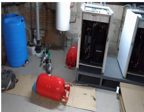
Componentes del sistema de calefacción
