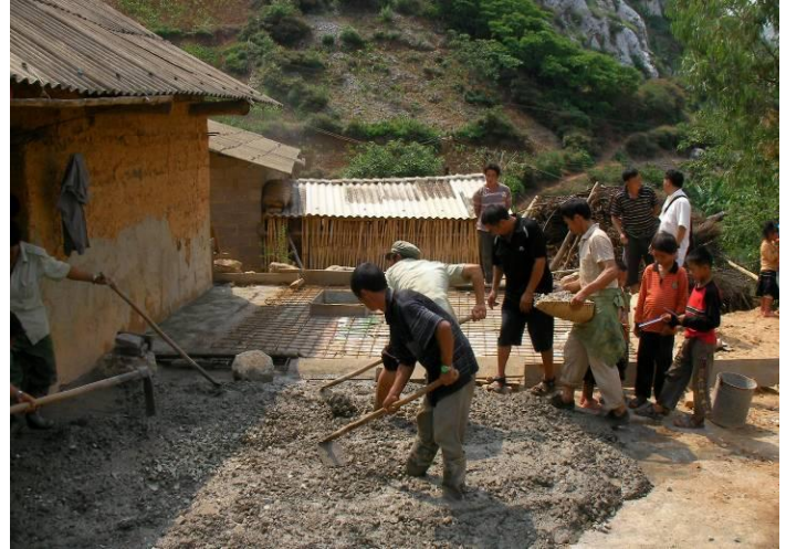
Una de las nuevas cisternas en construcción
