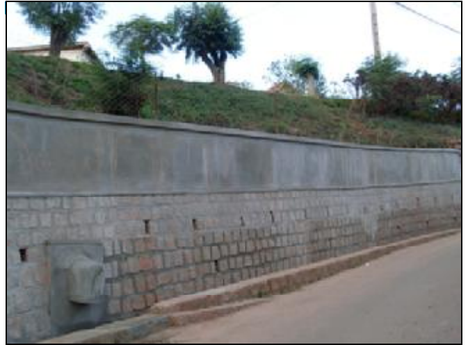
El nuevo muro de retención en la Casa San Vicente
