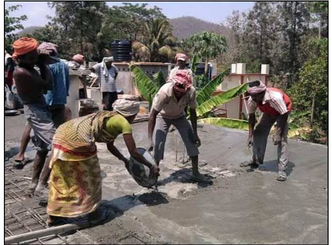
Trabajadores construyendo el tejado del anexo
