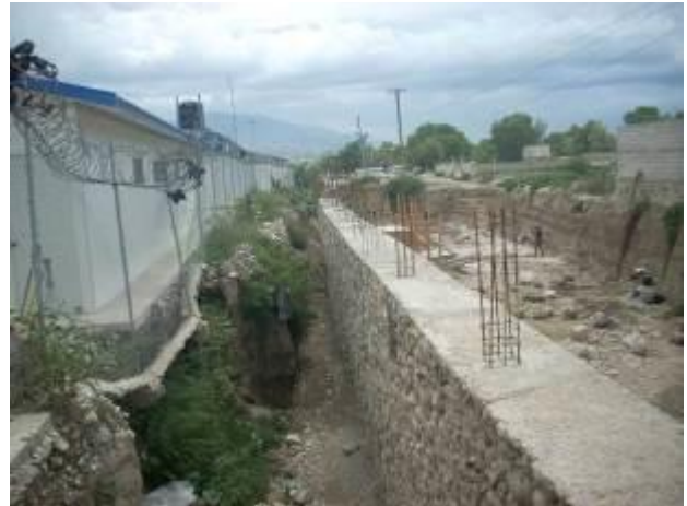
El muro de contención en construcción por la escuela
