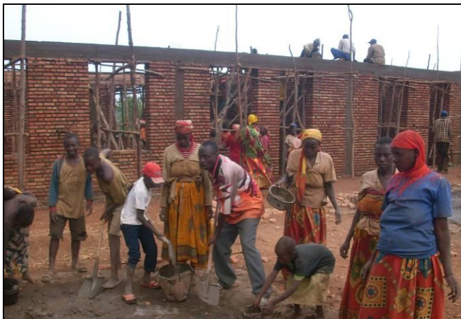
Estudiantes y sus familias ayudando en la construcción de la escuela
