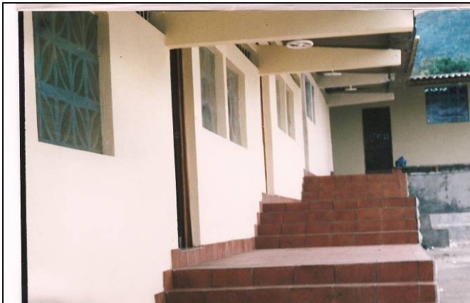
La Casa de Retiro restaurada Padre Antonio Comte
