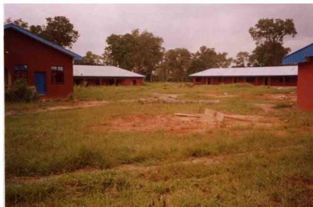
El nuevo seminario de Ogobia. De izquierda a derecha: la capilla, la administración y dos edificios de habitaciones.
