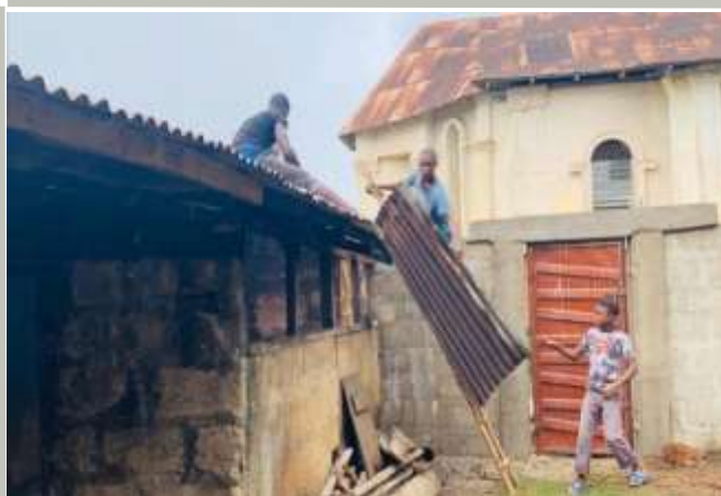
Jóvenes locales que ayudan con la demolición de las láminas del techo
