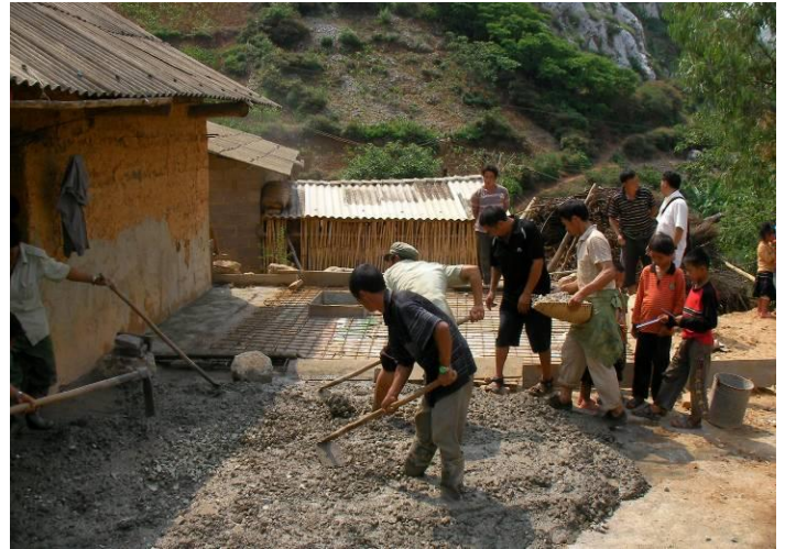
L'une des nouvelles citernes en construction
