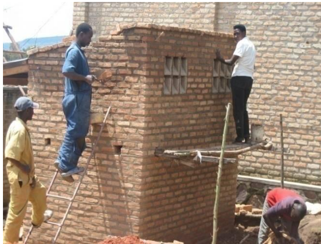
La nouvelle salle de bains en construction
