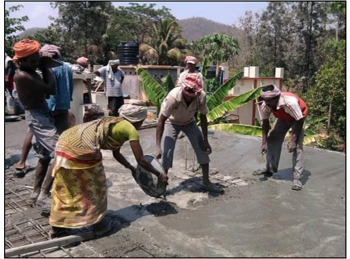
Travaux de construction du toit de la partie ajoutée du presbytère
