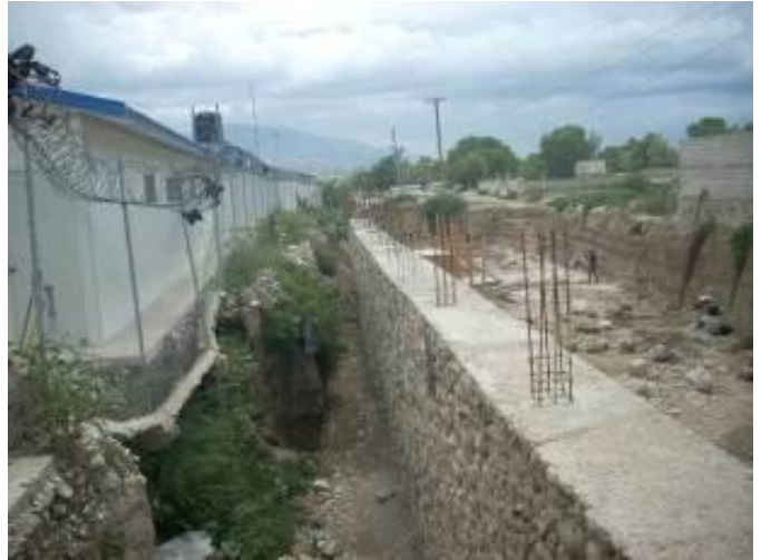
Le mur de soutien en construction par l'école
