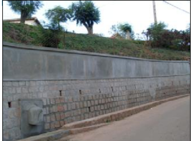
Le nouveau mur de rétention à la Maison Saint-Vincent
