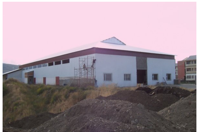
Le nouveau gymnase en construction par la Paroisse de la Vierge de la Médaille Miraculeuse Milagrosa
