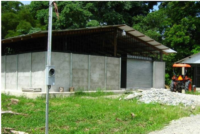
Le nouveau Centre de traitement des aliments et le tracteur de la paroisse Santiago Apóstol de Talamanca
