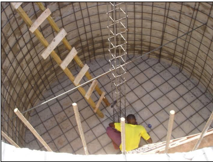
Le nouveau réservoir d'eau presque terminé
