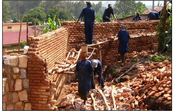
Construction du nouveau mur du Séminaire Saint-Vincent
