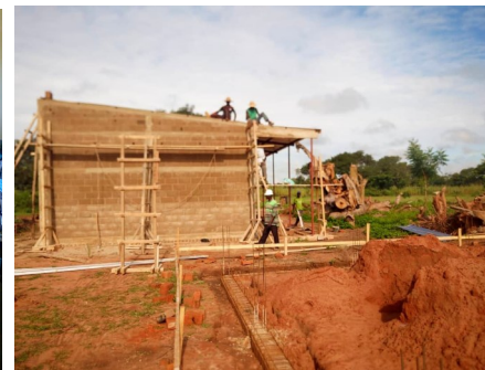
Le bâtiment pendant la construction
