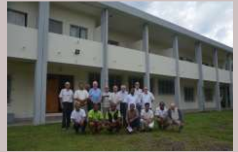
Madagascar: Rénovation de la maison de l'administration centrale.
