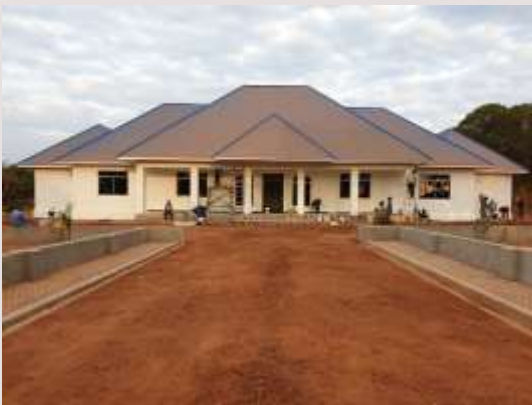
Tanzanie: Agrandissement de la Maison d'administration régionale et ajout de 20 chambres pour des retraites et des séminaires.
