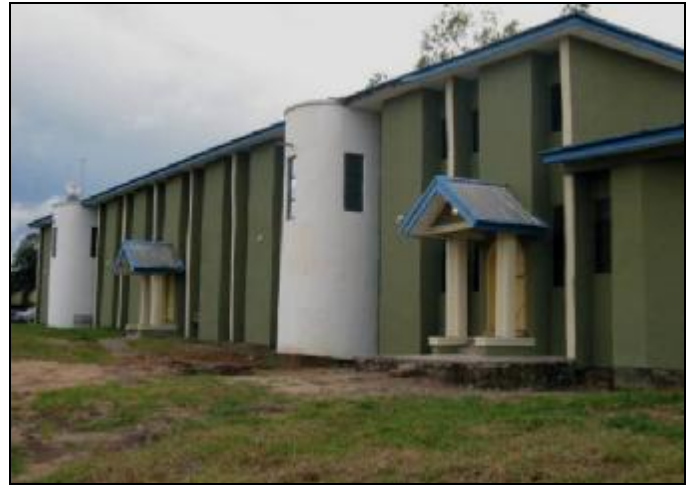
El nuevo edificio del Postulantado ya terminado
