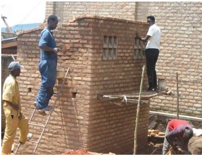
Los nuevos servicios sanitarios y la ducha en construcción
