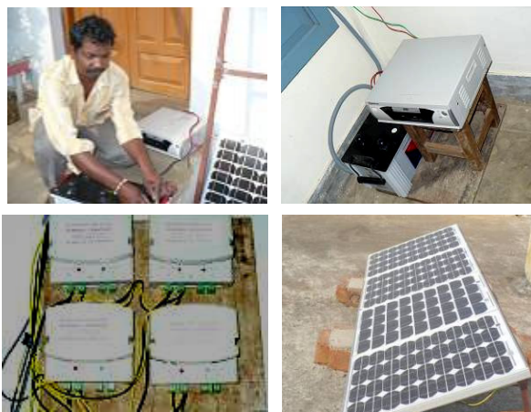
Un técnico instala los distintos elementos de la unidad de energía solar en un albergue en India Norte
