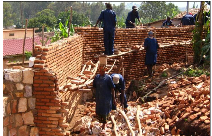
Construyendo el nuevo muro en el Seminario San Vicente
