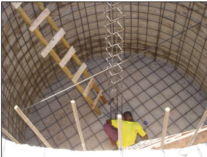
El nuevo depósito de agua casi terminado
