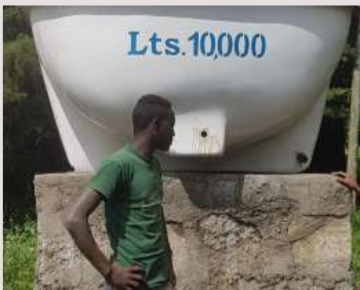
Etiopía: Perforación de un pozo en el complejo Parroquial en Shishinda.
