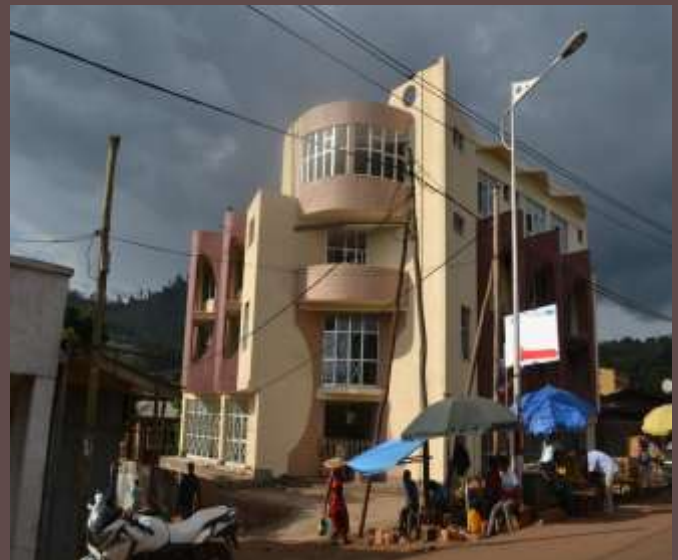
Etiopía: Construcción de un nuevo Seminario Interno en Jimma Bonga.
