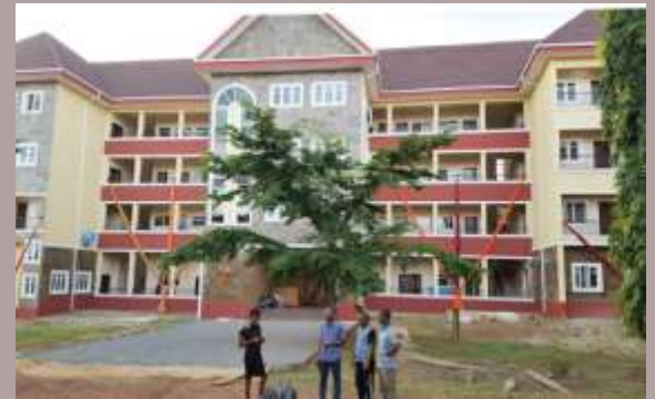
Nigeria: Construcción del nuevo edificio para seminaristas COVIAM Common Theologate en Enugu.
