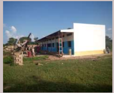
Chad: Construcción de tres aulas para la Escuela Secundaria Saint Jean-Baptiste en Bebalem.
