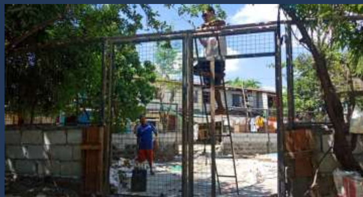
Filipinas: Construcción de un patio de recreo y juegos.
