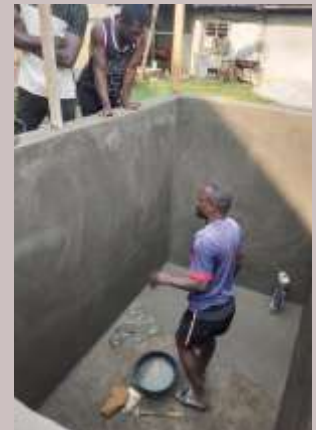
Camerún: Construcción de una piscifactoría para la seguridad alimentaria
