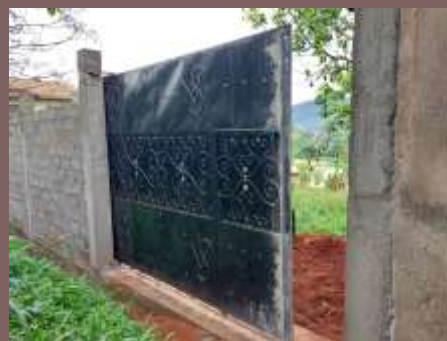
Camerún: Construcción de un muro de contención para el Seminario Mayor San Vicente de Paúl, en Yaundé
