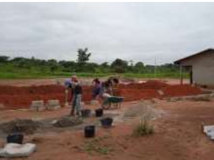
El comienzo de la construcción de las nuevas aulas
