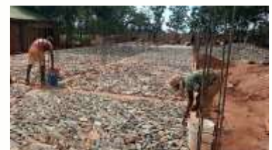
Construcción del edificio del seminario mayor de Morogoro, Tanzania
