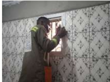
Renovación de la casa pastoral de Douala Camerún
