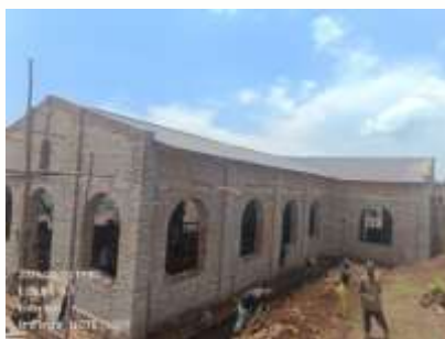
Reconstrucción de la iglesia derrumbada de Kidasha, Burundi
