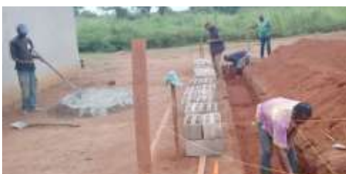
Nuevo edificio escolar para la Escuela San Vicente de Paúl de Belita II, Batouri, Camerún
