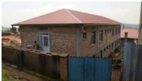
Construcción de un seminario interno y salas de reuniones, Ruanda
