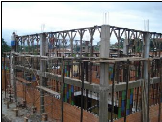
Le centre paroissial Virgen María de los Remedios en reconstruction
