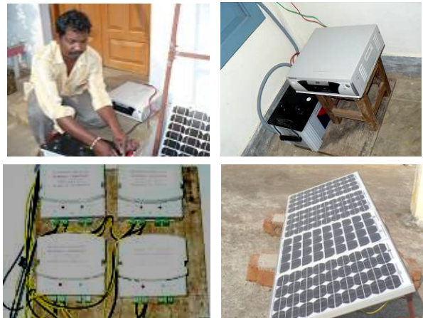
Un technicien installant les divers composants d'une unité d'inverseur solaire dans un foyer en Inde du Nord
