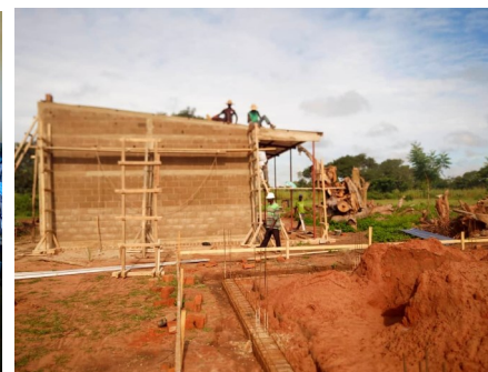
Le bâtiment pendant la construction
