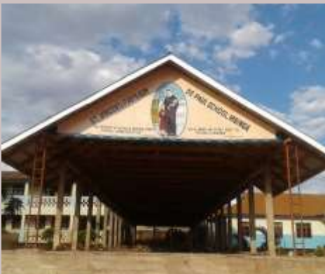
Tanzanie: Construction d'un pavillon en plein air à l'école De Paul
