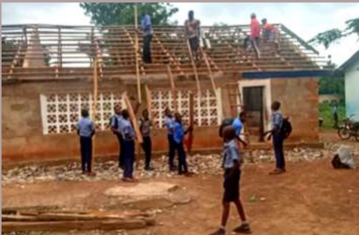
Nigeria: Couverture de l'auditorium polyvalent du St. Mary's College
