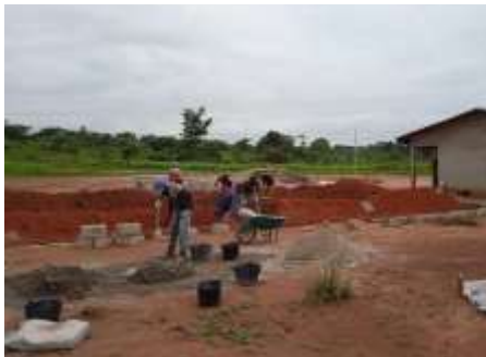
Le début de la construction des nouvelles salles de classe
