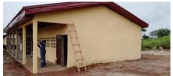
Ci-dessus : La construction touche à sa fin
