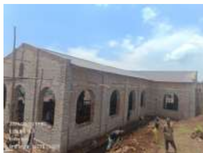
Reconstruction de l'église effondrée de Kidasha, Burundi
