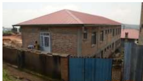
Construction d'un séminaire interne et de salles de réunion, Rwanda
